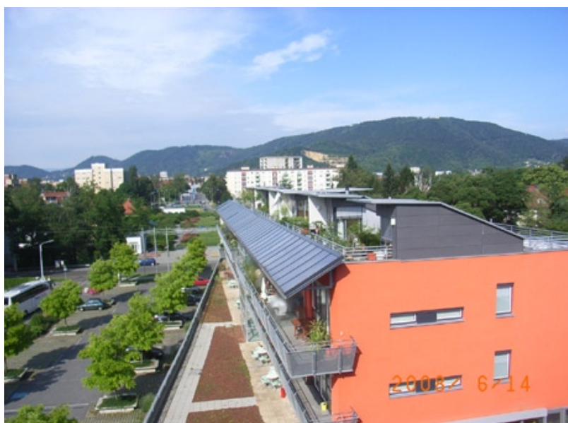
Ryc. 2. Zespół mieszkaniowy „Theodor Korner Strasse” Graz. Elewacja południowa z kolektorami. Fot. autora
