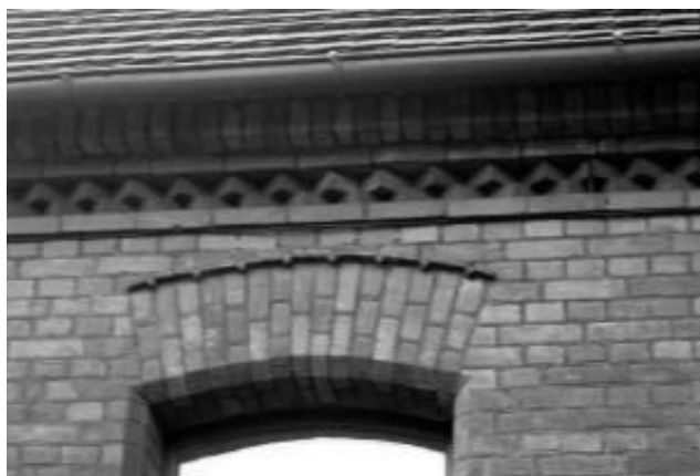
Ryc. 6. Zdobnictwo w budynku mieszkalnym w Krasiejowie, 2004, fot. autorka
