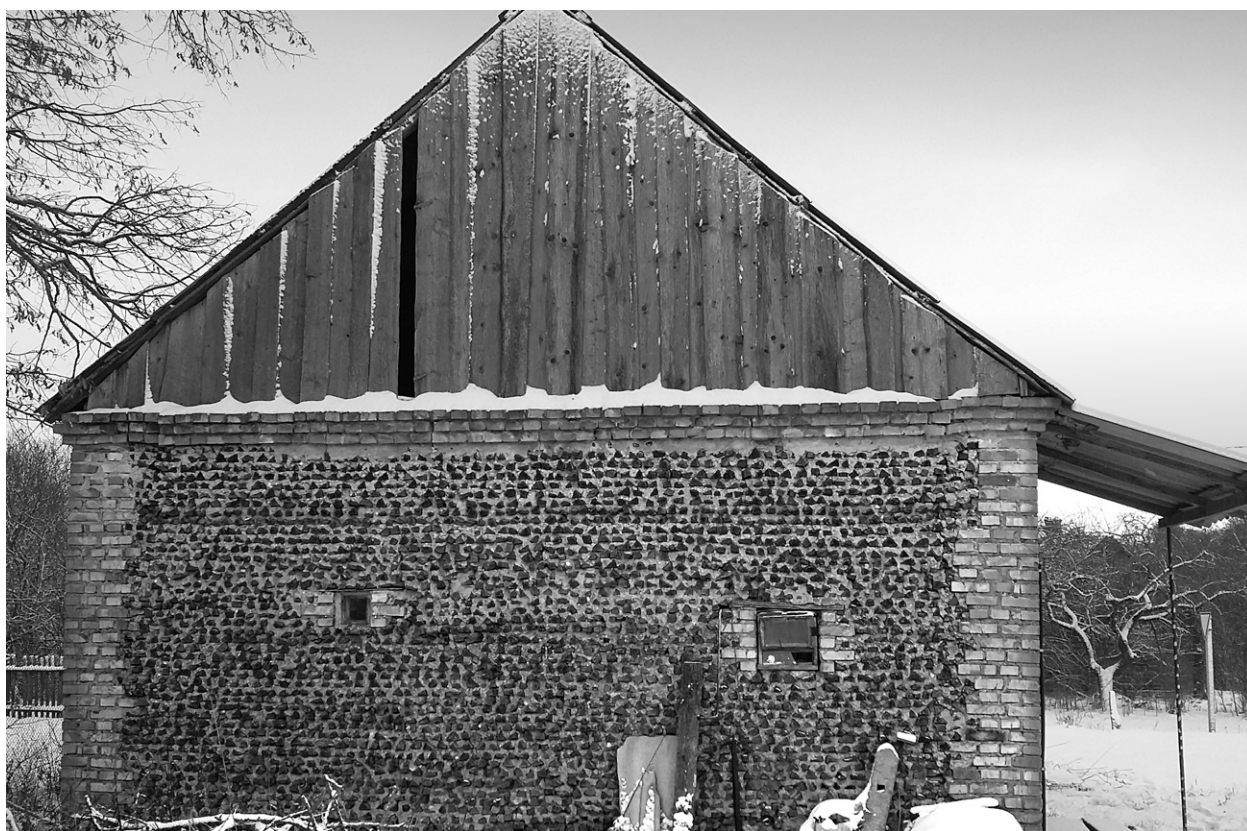
Рис. 13. Fragment ściany domu w miasteczku Strubnica, ul. Sadowaja 1; fot. J. Mazets Fig. 13. A wall of a house in Strubnitsa, Sadovaya St. 1; photo by Y. Mazets Рис. 13. Стена дома в д. Струбница, улица Садовая 1; фото: Ю. Мазец
