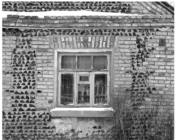
Рис. 11. Fragment ściany domu w miasteczku Strubnica, ul. Sadowaja 40; fot. J. Mazets Fig. 11. Stackwall house in Strubnitsa, Sadovaya St. 40; photo by Y. Mazets Рис. 11. Стена дома в д. Струбница, улица Садовая 40; фото: Ю. Мазец
