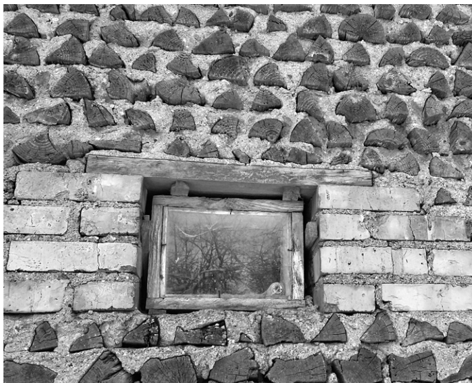
Рис. 10. Fragment ściany domu w miasteczku Strubnica, ul. Sadowaja 40; fot. J. Mazets Fig. 10. A wall of a house in Strubnitsa, Sadovaya St. 40; photo by Y. Mazets Рис. 10. Стена дома в д. Струбница, улица Садовая 40; фото: Ю. Мазец
