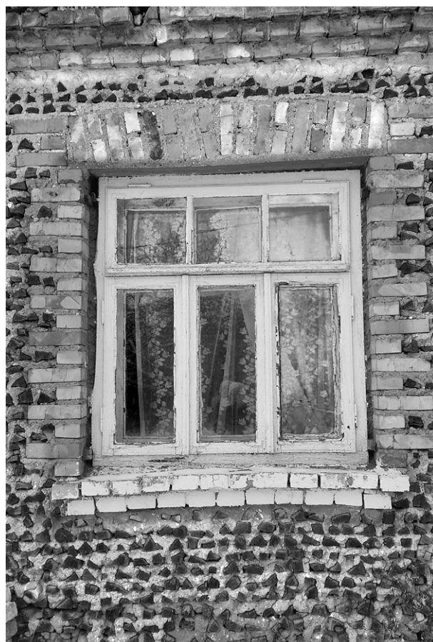
Рис. 14. Fragment ściany domu w miasteczku Strubnica, ul. Sadowaja 1; fot. J. Mazets
