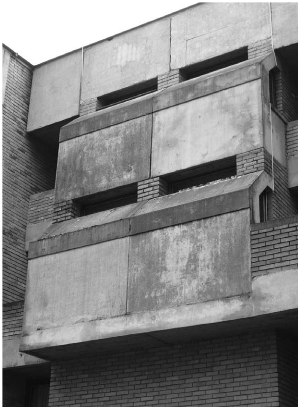
Ryc. 17. Kolegium Polonijne UJ – żelbetowe wykusze. Fot. autor
