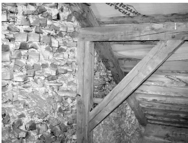
Ryc. 3. Widok odsłoniętych polan w ścianie szczytowej domu przy ul. 1 Maja 6 w Uhowie. Fot. M. Kusznerko
