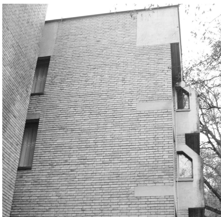
Ryc. 25. Tomasz Mańkowski i Dariusz Kozłowski, budynek Kolegium Polonijnego im. Kazimierza Pułaskiego w Krakowie, 1975-1991. Fot. autor
