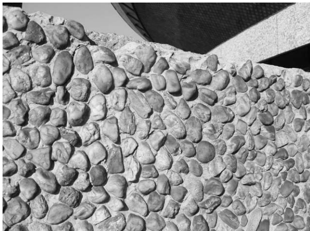
Ryc. 13. Maciej Gintowt, Maciej Krasieński, Andrzej Żórawski, hala sportowo-widowiskowa „Spodek” w Katowicach, 1960-1971. Fot. autor
