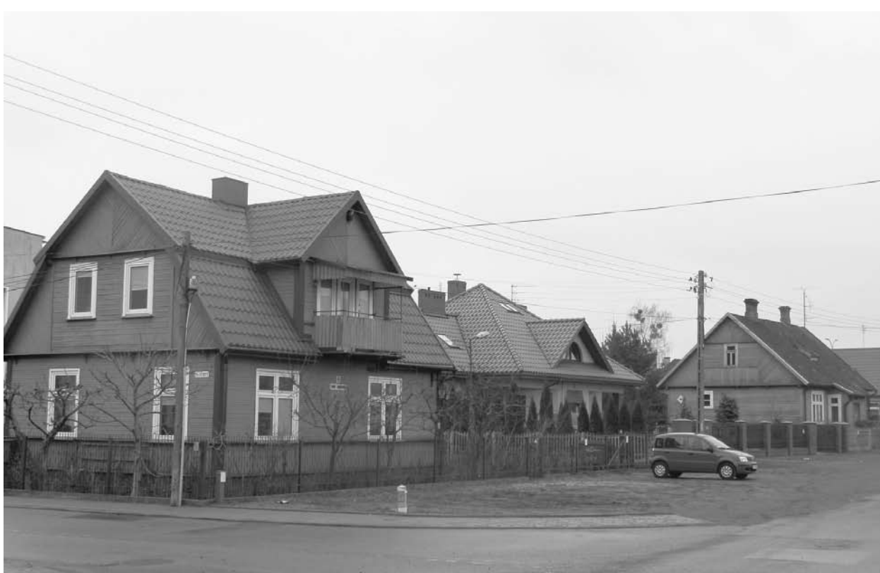
Ryc. 5. Ulica Pod Krzywą w Białymstoku. Wprowadzony pomiędzy tradycyjną zabudowę budynek swoim usytuowaniem poza linią zabudowy i profilem dachu wyraźnie zaburza istniejący ład przestrzenny ulicy. Fot autor.
