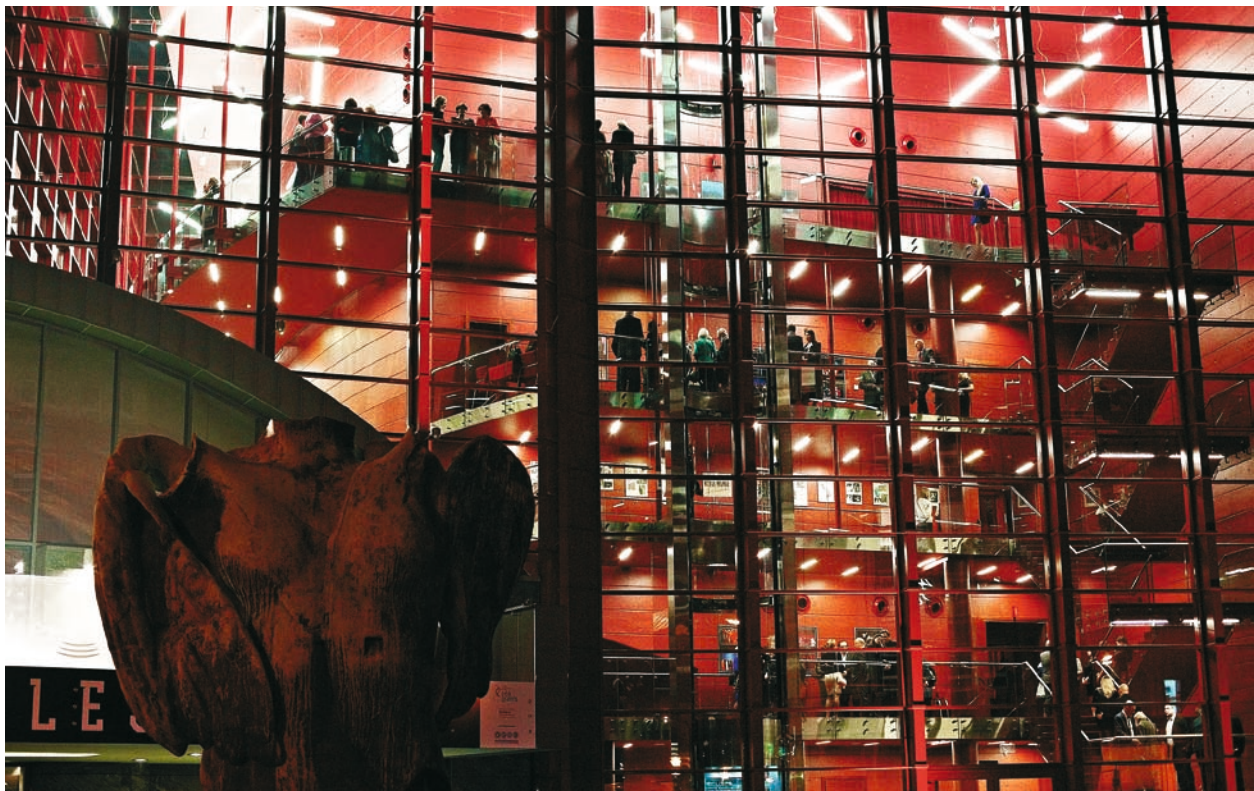
Ryc. 15. Opera Krakowska: dominująca kolorystyka czerwieni wnętrza widowni przenika do zewnętrznej przestrzeni publicznej miasta; źródło: © Romuald Loegler, Atelier Loegler Architekci.
