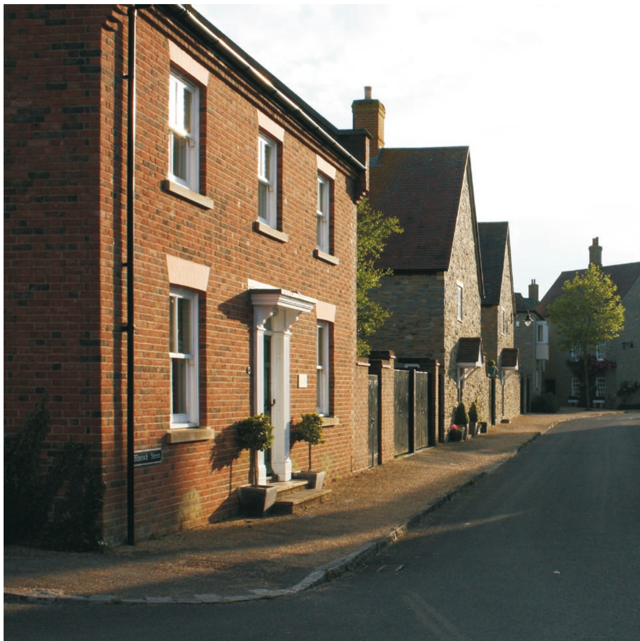
Ryc. 8. Poundbury, dzielnica Middle Farm. Hintock Street, widok w kierunku zachodnim. Zwracają uwagę nadproża ceglane wg wzorca z ryc. 6a) oraz sposób wykonania zadaszeń nad wejściami; źródło: A. Zaguła 2014
