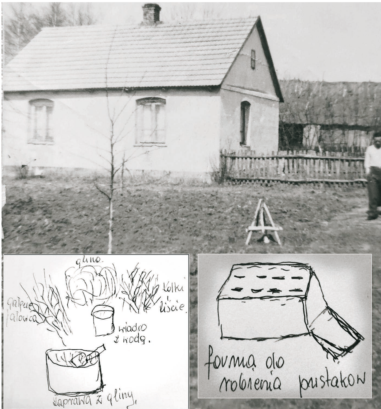
Fig. 3. An archival photograph of the earthen farmhouse; and the Interviewee's drawings of how building materials were made (cob for rammed walls, and a hollow brick mould) ; source: the family archive of Krystyna Kołakowska Ryc. 3. Archiwalne zdjęcie domu glinożalowego oraz rysunki Respondentki, przedstawiające przygotowanie budulca (glinożalowego oraz pustaków); źródło: z rodzinnego archiwum Krystyny Kołakowskiej
