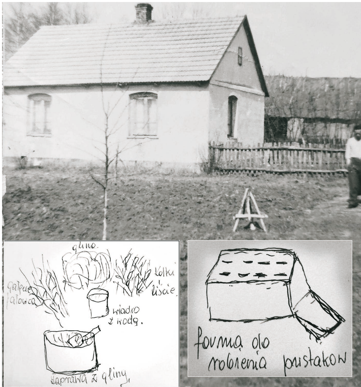
Fig. 3. An archival photograph of the earthen farmhouse; and the Interviewee's drawings of how building materials were made (cob for rammed walls, and a hollow brick mould) ; source: the family archive of Krystyna Kołakowska Ryc. 3. Archiwalne zdjęcie domu glinoałowcowego oraz rysunki Respondentki, przedstawiające przygotowanie budulca (glinoałowcowego oraz pustaków); źródło: z rodzinnego archiwum Krystyny Kołakowskiej
